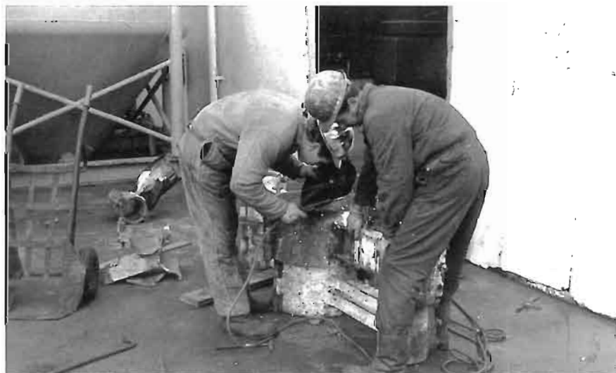
Lima og en sveiser setter klamper rundt mudraiseren på «Ocean Viking».
