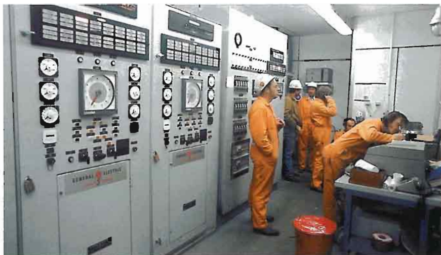
Kontrollpanel for turbine fra General Electric på Ekofisk 2/4 FTP
