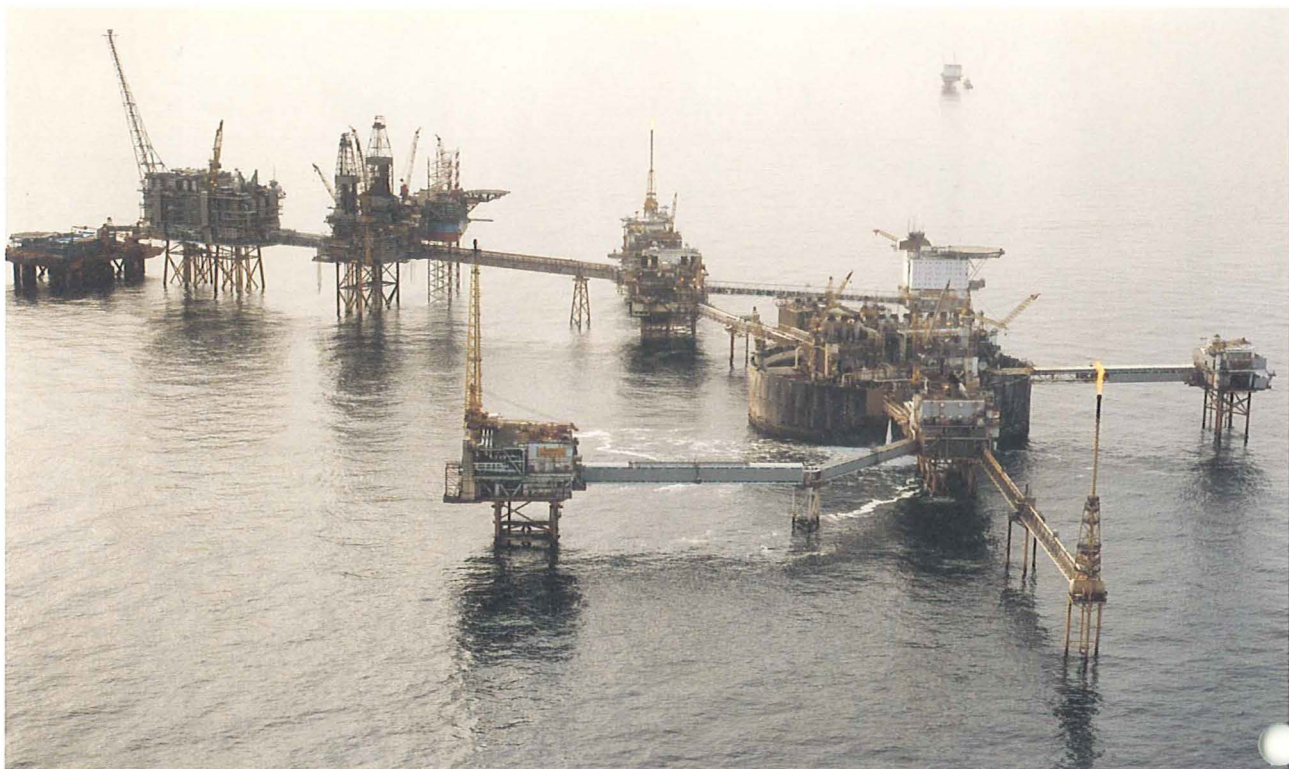
Ekofisk-senteret sett fra nord. I sluttdisponeringssammenheng blir broer og plattformer nord for Ekofisk 2/4 C betegnet Ekofisk-senter nord.
